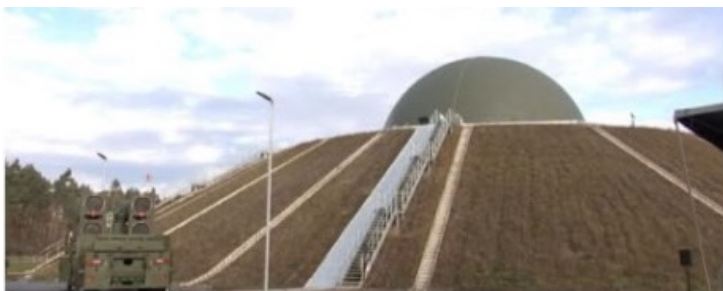
Quelle Bild 1: https://www.rbb24.de/panorama/beitrag/2025/12/brandenburg-schoenewalde-holzdorf-luftabwehrsystem-arrow-3-start.html
